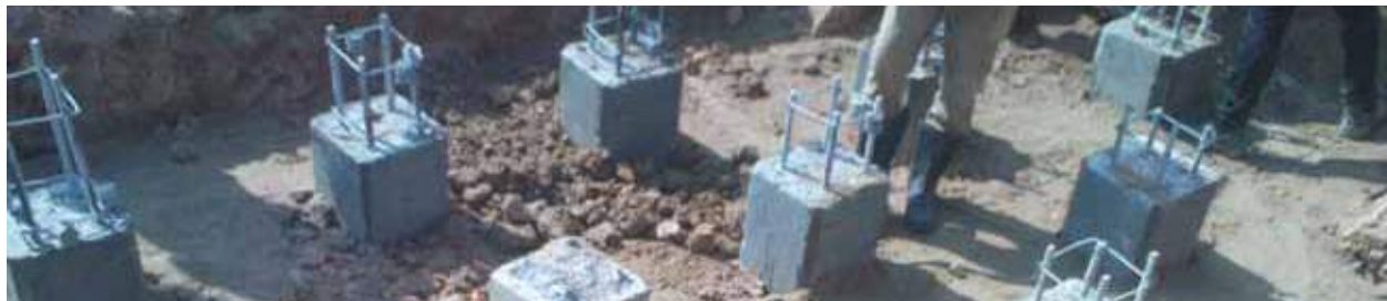
Travaux de fondation du bâtiment scolaire de l'Ecole de Gestion et Vente-Août 2013
